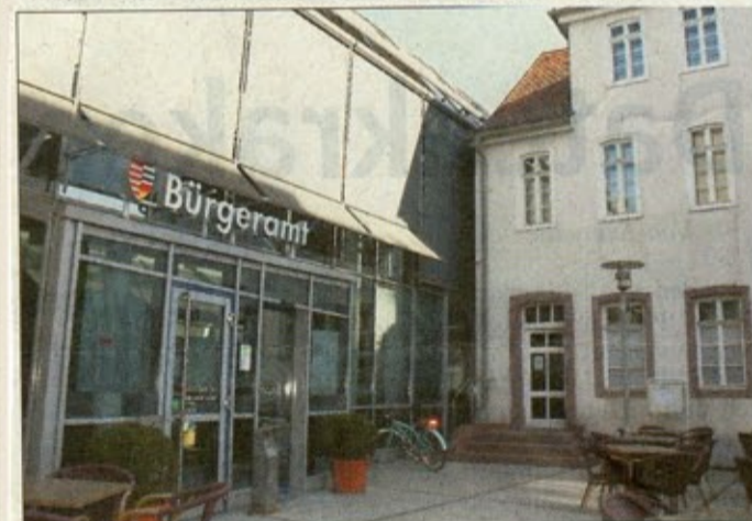
Das Alte Stadthaus wurde 1781 als erste deutsche Schule des hugenottischen Orts errichtet und 1891 für die Bürgermeisterei erweitert. Heute befindet sich dort das Bürgeramt.
