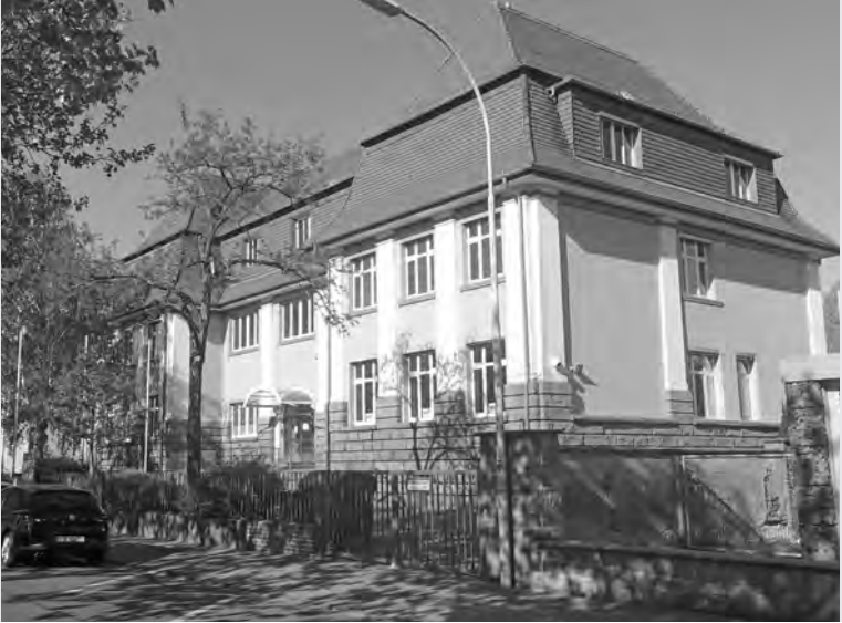
Hauptgebäude der ehemaligen Goetheschule 2020
